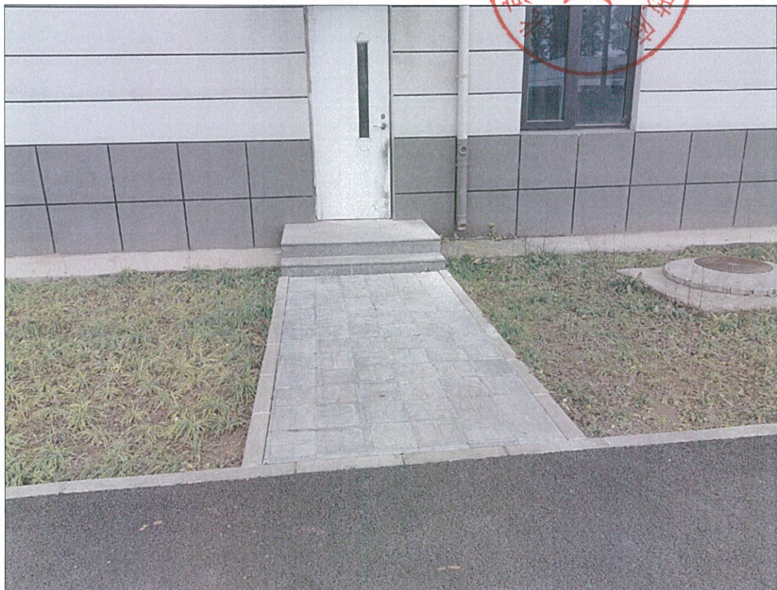
透水砖铺装和集雨式整地
