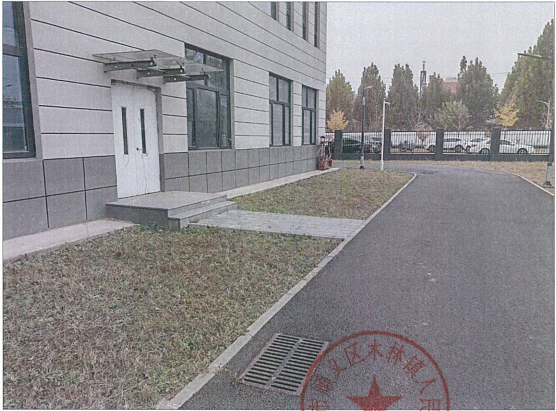
透水砖铺装和集雨式整地
