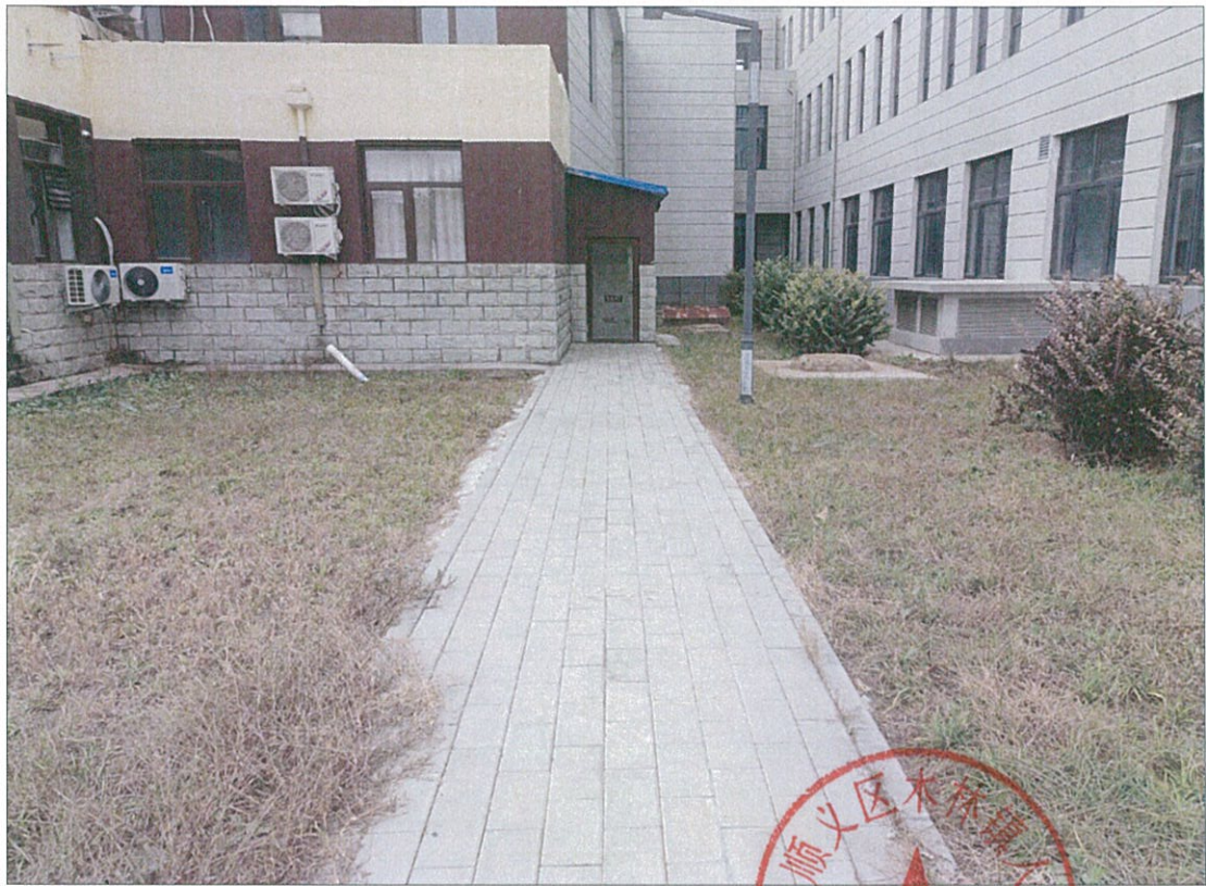
透水砖铺装和集雨式整地
